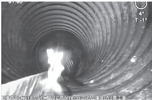
写真-2 既設管きょ状況 (φ 800 部分)
