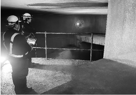
写真-1 球体ドローン調査状況
