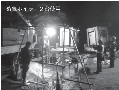
写真-10 施工状況 (その1)
