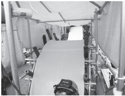
写真-8 引き込み状況 (その3)
