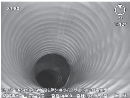
写真-14 出来形(既設管φ800部分)
