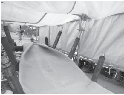
写真-7 引き込み状況 (その2)
