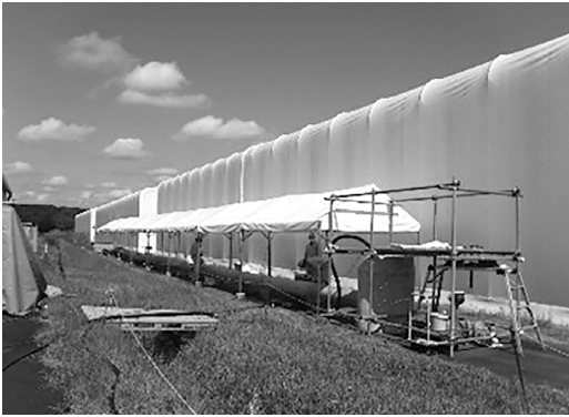
① φ 300 施工性試験状況
