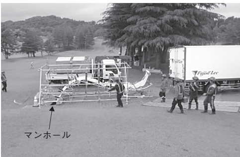
写真-3 引き込み装置 (遠景)
