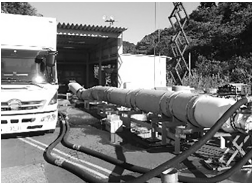
② φ 600 施工性試験状況
