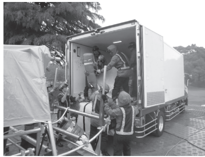
写真-6 引き込み状況 (その1)
