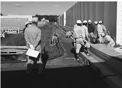
③ φ 600 施工延長 (100 m) 確認
