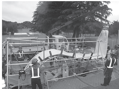
写真-9 引き込み状況 (その4)
