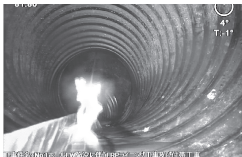
写真-2 既設管きょ状況 (φ 800 部分)
