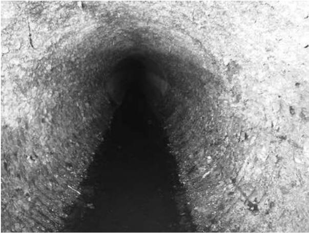
排水が触れる管下部を中心に進む腐食
