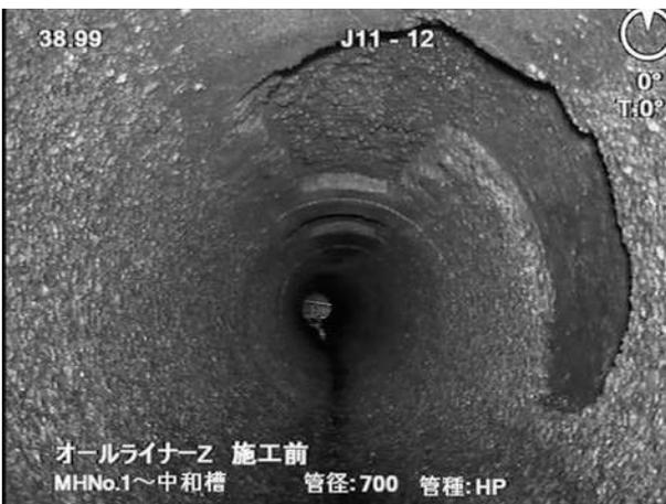
覆工した部分が大きく剥落した管内状況
