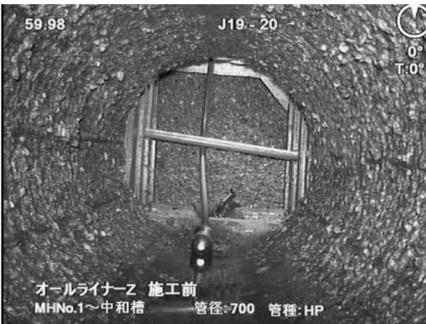
骨材が露になり鉄筋も浮き出している
