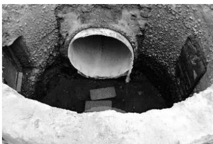
写真-8 手順① 実施工 (仮の既設管形成)
