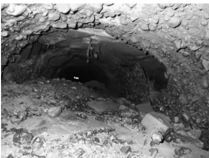
写真2 腐食が進み大きく破損している箇所
