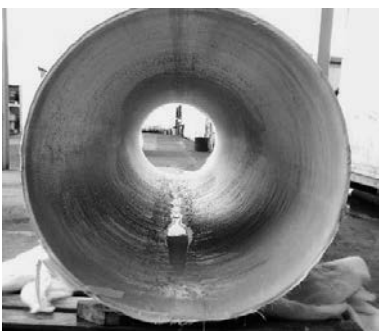
写真4 手順① 仮の既設管形成
