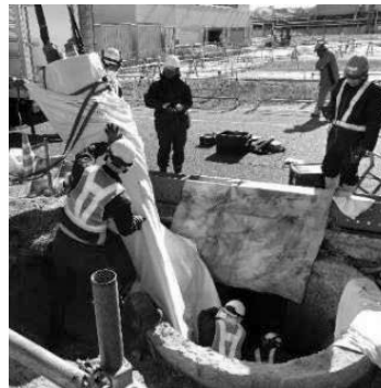
写真-7 手順① 実施工 (オールライナー+全面プロテクトホース)
