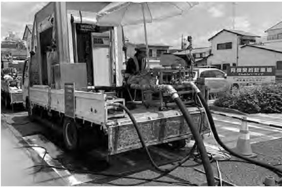
蒸気硬化による養生作業のようす
