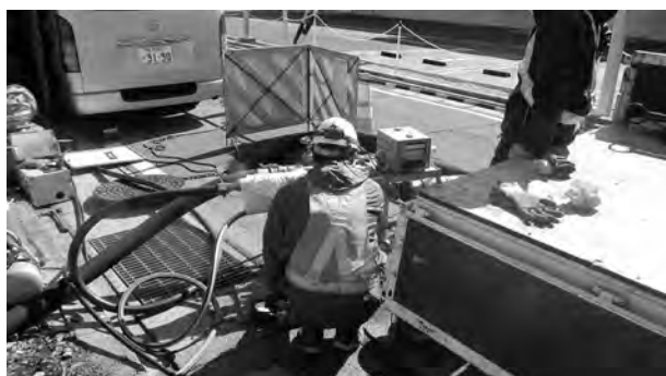
写真－3 デモ施工のようす（オールライナー工法） 管清工業（株）社の＜蒸気施工＞現場における「オールライナー工法」時短施工の実施状況の確認と施工圧力設定の手順やポイントについて検証
