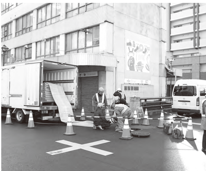
写真-1 豊橋市内で実施したオールライナーZ工法(薄肉ライナー)の施工状況
