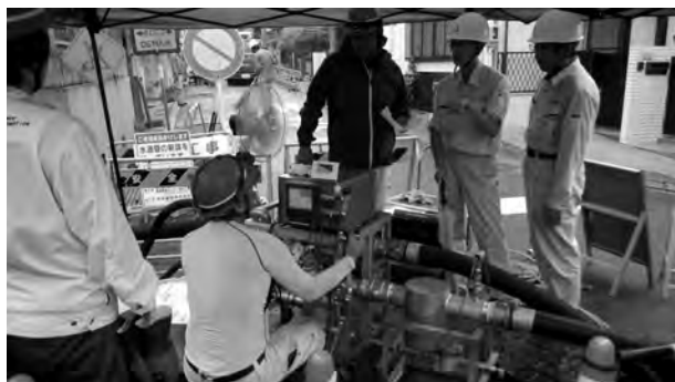
写真－2 デモ施工のようす（オールライナーⅡ工法） （有）東海維持管理興業社の＜蒸気施工＞現場における「オールライナーⅡ工法」時短施工の実施状況の確認と施工圧力設定の手順やポイントについて検証
