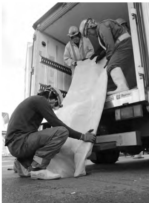
写真-2 ライナー材の肉厚を薄くしたことで引込み時の身体的負担も軽減できました
