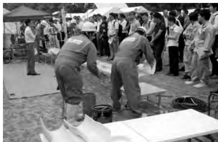
下水道管更生技術施工展 2019 金沢における デモ施工のようす
