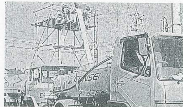
施工中のオールライナー工法
