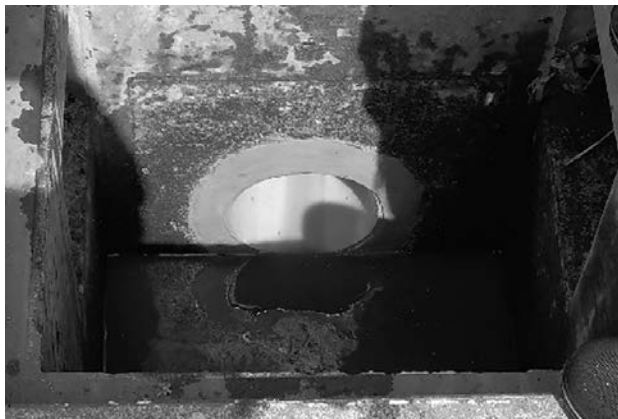
写真-7 管口仕上げ後 (φ 230 到達側)
