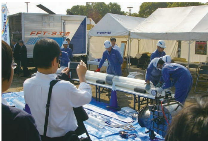
下水道管更生技術施工展 2015 岡山でのようす
