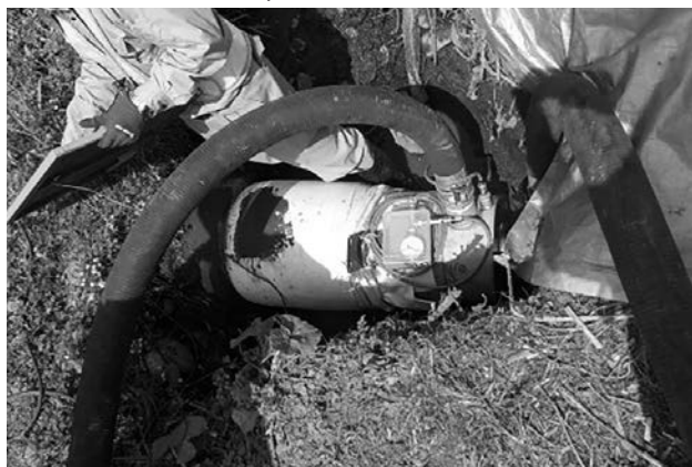
写真－4 拡径状況（ \phi 450 発進側）
