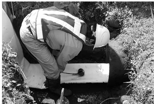
写真－3 位置合わせ確認用カメラ挿入
