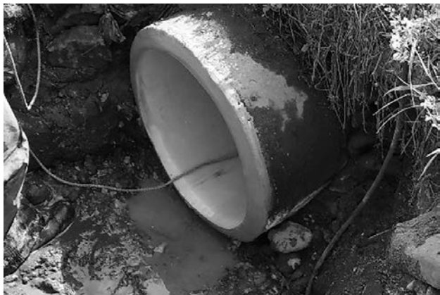
写真-6 管口仕上げ後 (φ 450 発進側)
