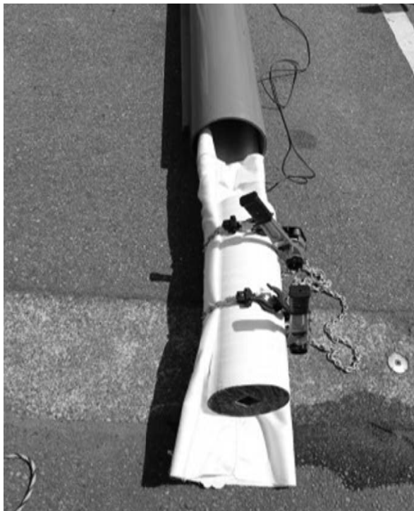
写真-2 実技研修用にセットされた模擬管路と更生材
