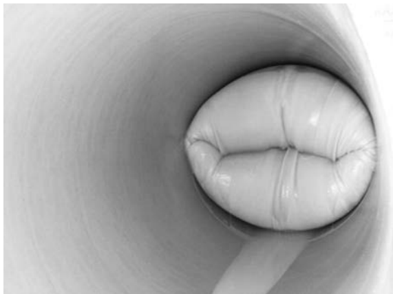
写真－4 拡径硬化状況
