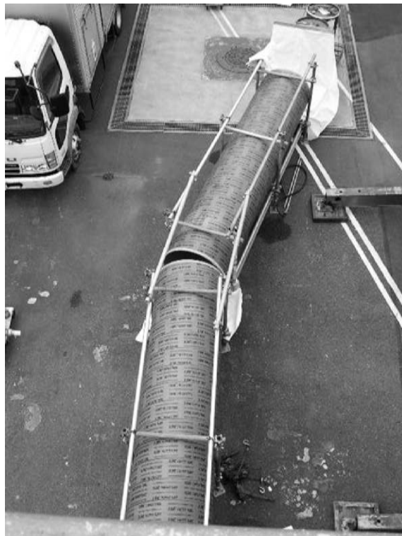
写真－2 反転および治具取り付け
