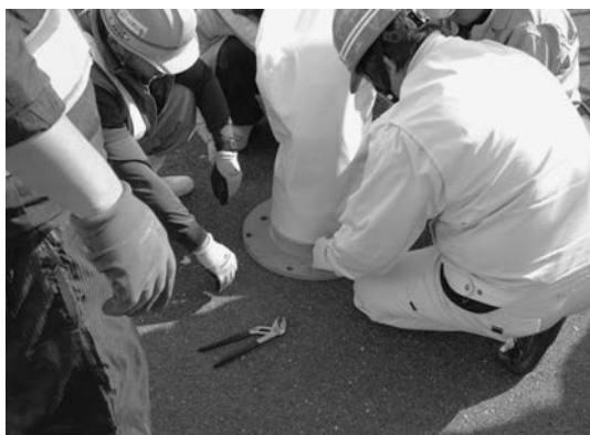
写真-4 反転治具取り付け作業
