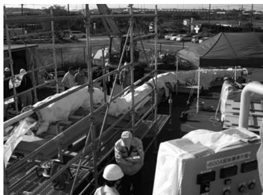
写真-1 模擬管路全景 (発進側より)
