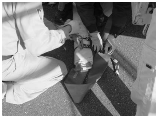
写真-3 ライナー・温水循環ホース結束作業
