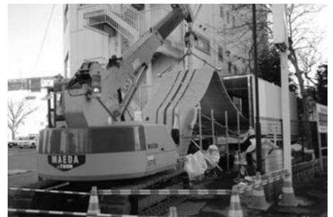
写真-4 角材を使った吊り上げ作業
