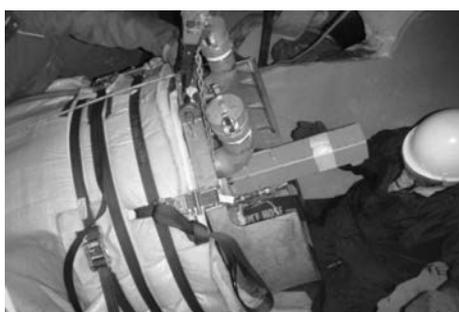
写真-6 ようやく拡張治具取り付け完了
