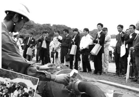
▲2回目のデモ施工時には雨も上がりました。写真は、模擬管に引き込んだライナーの拡径工の準備のようす
