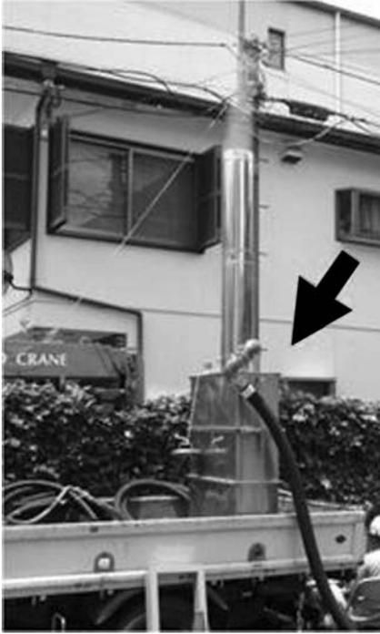
写真-4 矢印の先が消音器
