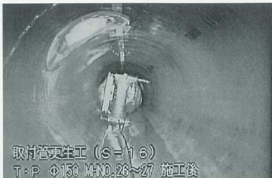
写真-3 施工後の管内
