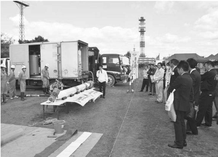
写真-6 デモ施工のようす
