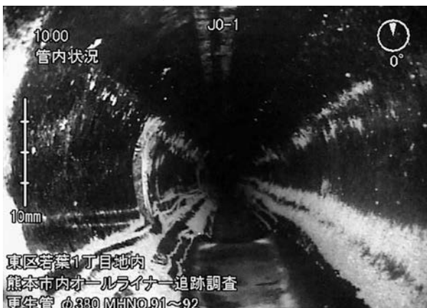
写真-4 管内状況 (スパン2)
