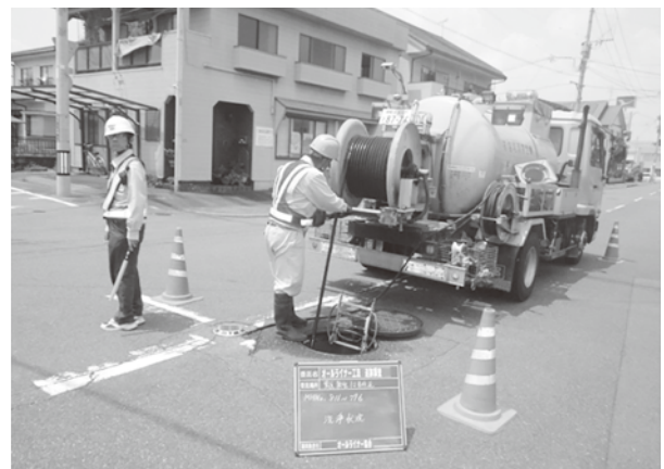
写真-7 調査作業の状況
