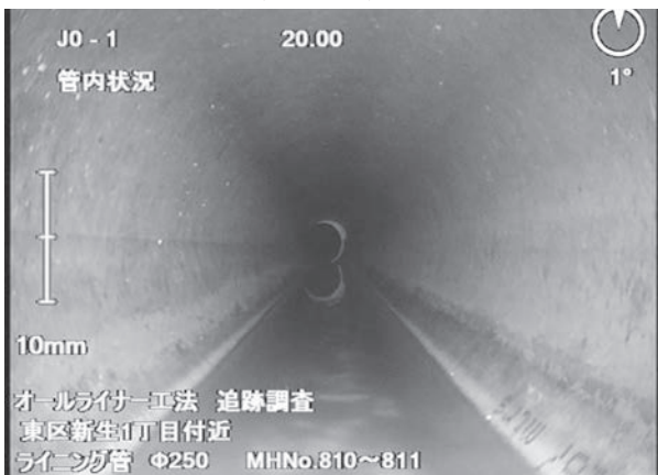
写真-10 管内状況 (スパン2)
