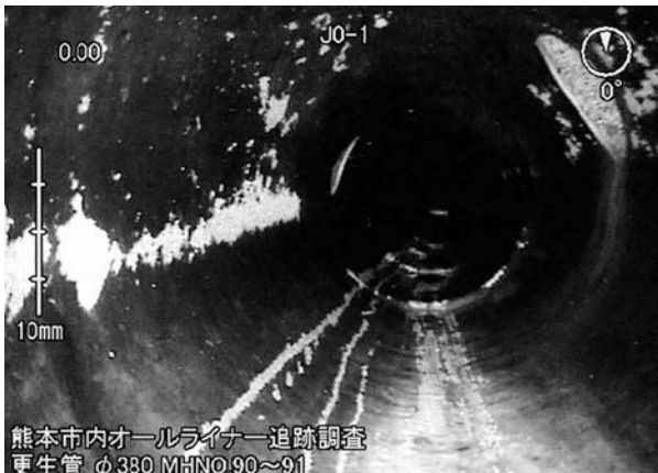
写真-2 管内状況 (スパン1)
