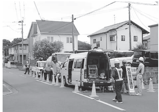
写真-5 調査作業の状況
