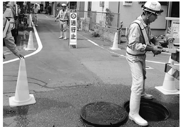
写真-1 調査作業の状況
