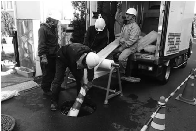
写真-14 引き込み状況
