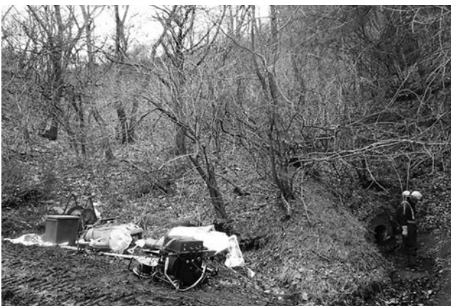
写真-2 現場状況
