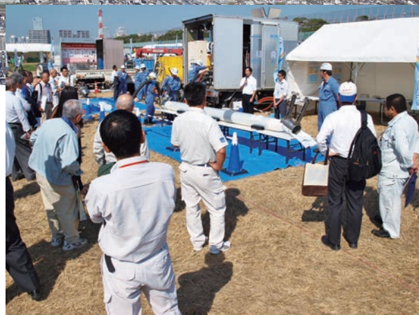
(上)琵琶湖畔には水を大切に使う暮らしの文化が息づきます (写真提供：(公社)びわこビジターズビューロー) (下)昨年10月20日に千葉県花見川終末処理場で開催された「下水道管更生技術施工展 2016 千葉」での施工実演
