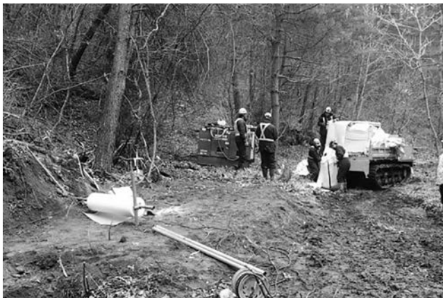
写真-4 スリップシート使用（引き込み）状況
