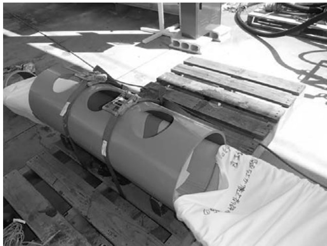
写真-2 ホース引き込み
