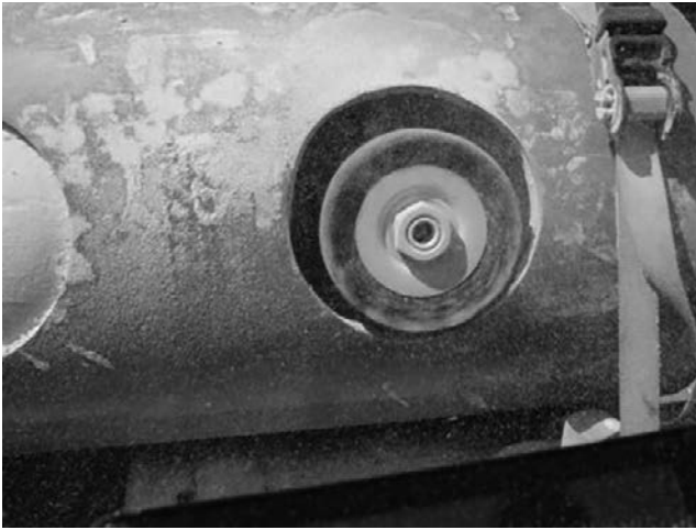
写真-5 穿孔仕上げ状況
