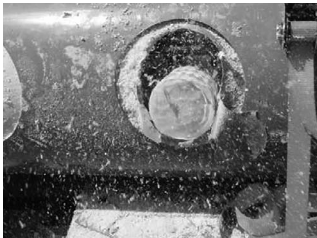
写真-4 穿孔状況(2)
