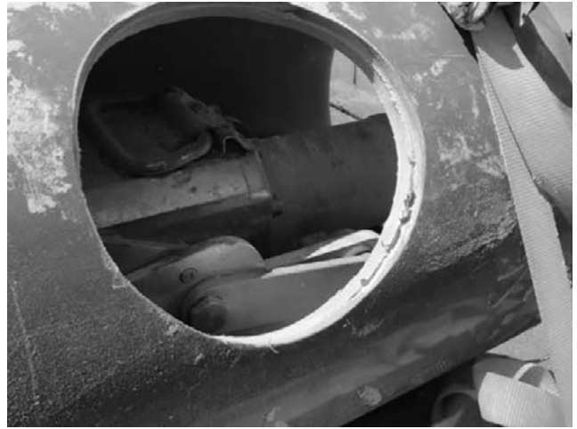
写真-6 穿孔後削り残し
