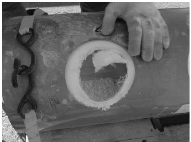
写真-8 穿孔状況(2)
