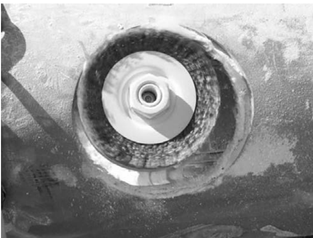
写真-9 穿孔仕上げ状況
