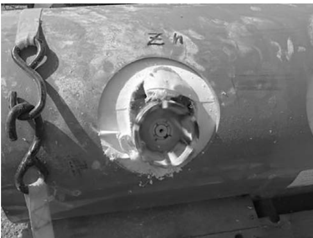
写真-7 穿孔状況(1)
