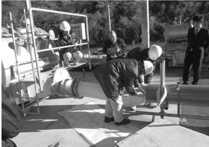
写真-9 オールライナーP工法の施工実演
