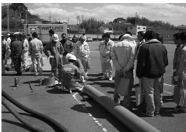
写真-6 中部支部施工研修会のようす
