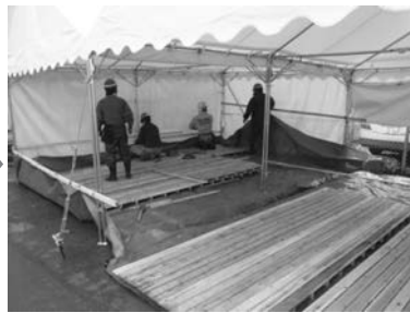
②テント組立て
