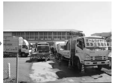
③車両・設備設置
