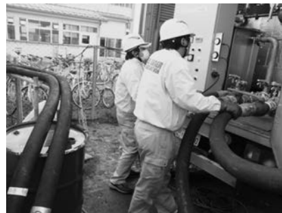
温水管理状況
