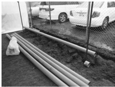
①排水設備設置
