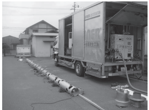
写真-4 勉強会用に作成した“穿孔管”
