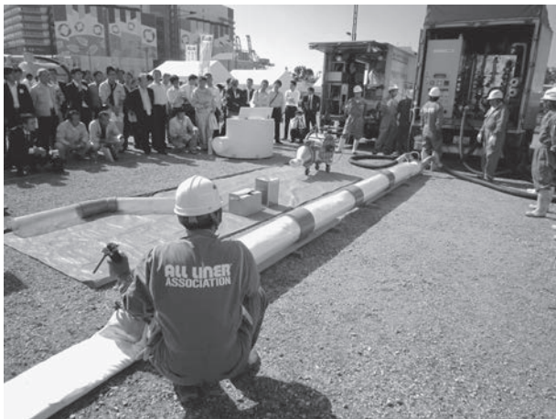
▲オールライナー工法のデモ施工。透明な模擬管へ更生材を引き込んだ後、拡径作業を行っているところ
